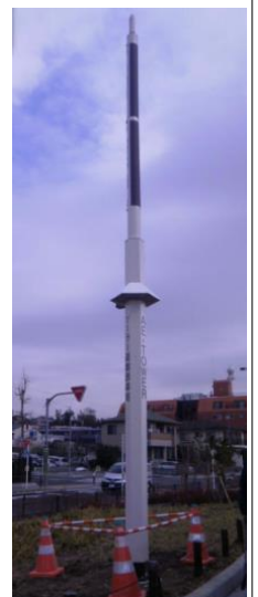
④設置直後の「AE-TOWER」
