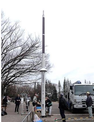
(寒空中で設置完了)
